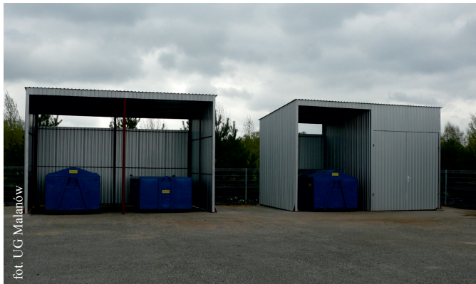
Punkt Selektywnej Zbiórki Odpadów Komunalnych
